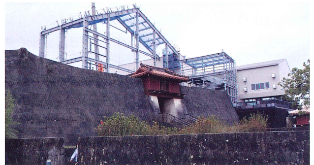
工事中の首里城 鉄骨の覆屋建設中 この下で正殿の再建工事が始まる 2023年3月撮影
